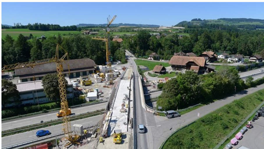
Luftbild der Brücke Kiesen-Jaberg von Ende August 2015 – der Verkehr rollt jetzt bereits auf der neuen Brückenhälfte links im Bild.
